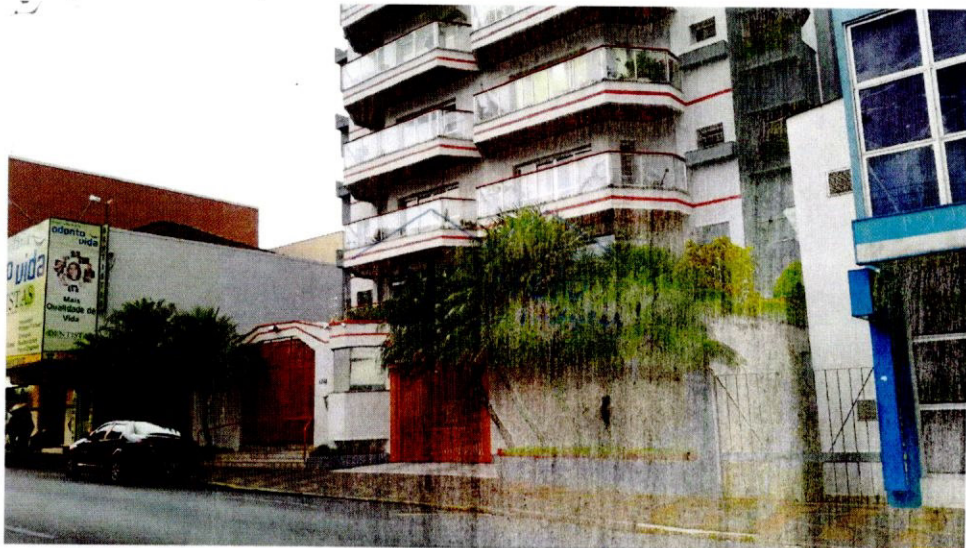
Ver César Ramos da Costa "Cesinha" – barulho em equipamentos de ar-condicionado em prédio do INSS que foi interdito pela Defesa Civil.
