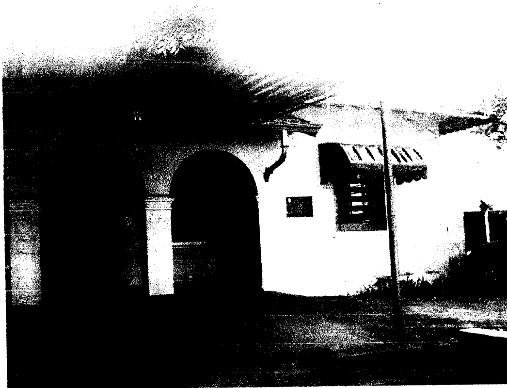
Condições precárias do toldo localizado na entrada da Unidade, bem como pintura - Vistoria realizada em 16/02/2011 - Vereador Eng o . Carlão
