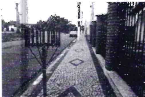
Al, Av Prudente de Moraes, Sentido Bairro Centro, Calçada com largura inferior 1,20mts
