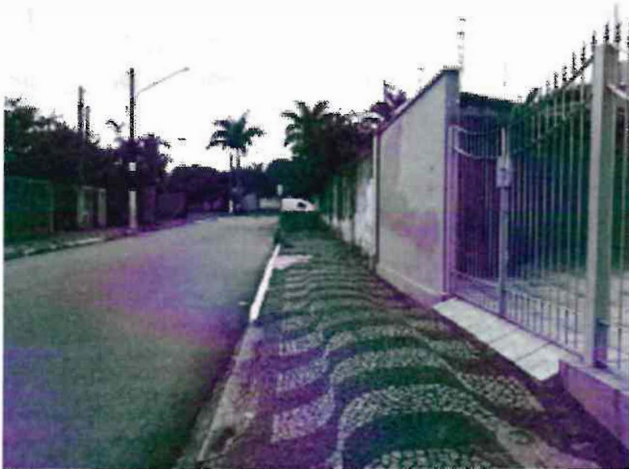
A1, Rua Capitão Maneco, trecho entre Rua da Saudade e Av. Prudente de Moraes, Lado Direito, Passeio Esburacado, Piso irregular, Raízes Aparentes
