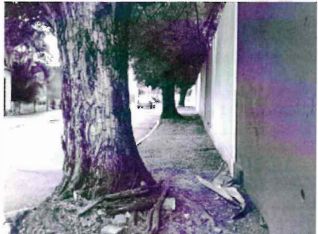
A1, Rua Capitão Maneco, trecho entre Rua da Saudade e Av. Prudente de Moraes, Lado Direito, Passeio Esburacado, Piso irregular, Raízes Aparentes
