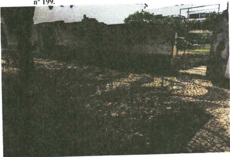
Ver César Ramos da Costa "Cesinha" – vistoria em lote localizado na Rua Iolanda Del Nero Barco, em frente ao nº 199.
