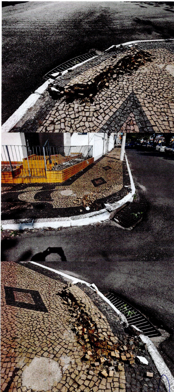
Ver César Ramos da Costa "Cesinha" - reparo em calçada localizada na Avenida Prudente de Moraes esquina com a Rua Yolanda Del Nero Barco.
