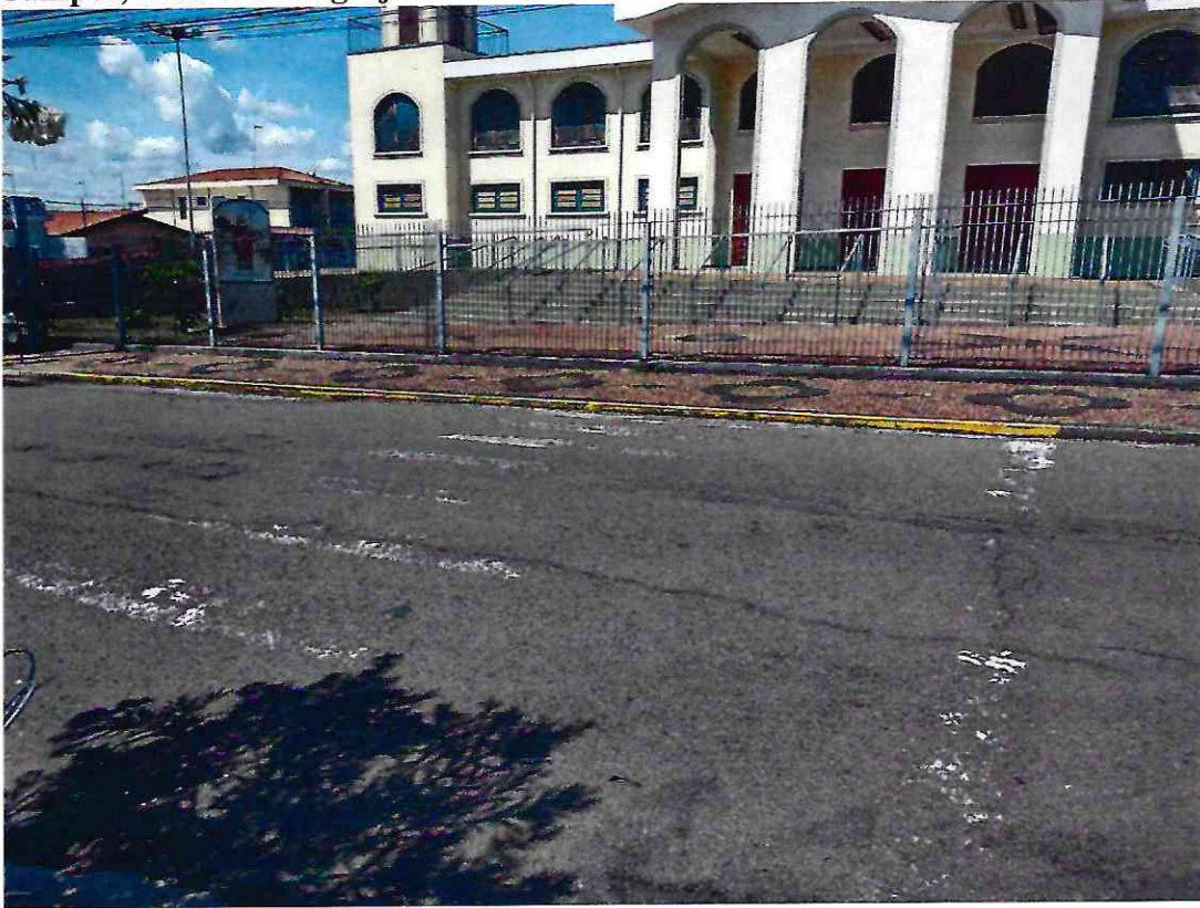
Ver César Ramos da Costa “Cesinha” – repintura de faixa de pedestres, Rua Siqueira Campos, em frente à Igreja São Judas Tadeu.
