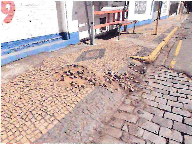
Ver César Ramos da Costa "Cesinha" - reforma de calçada na área central do município.
