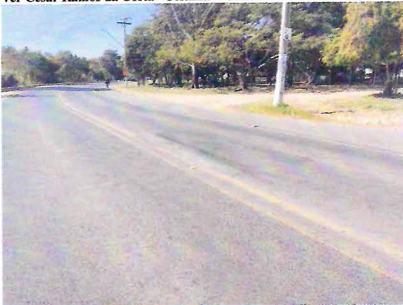
Ver César Ramos da Costa "Cesinha" - reforma em asfalto no Anel Viário.
