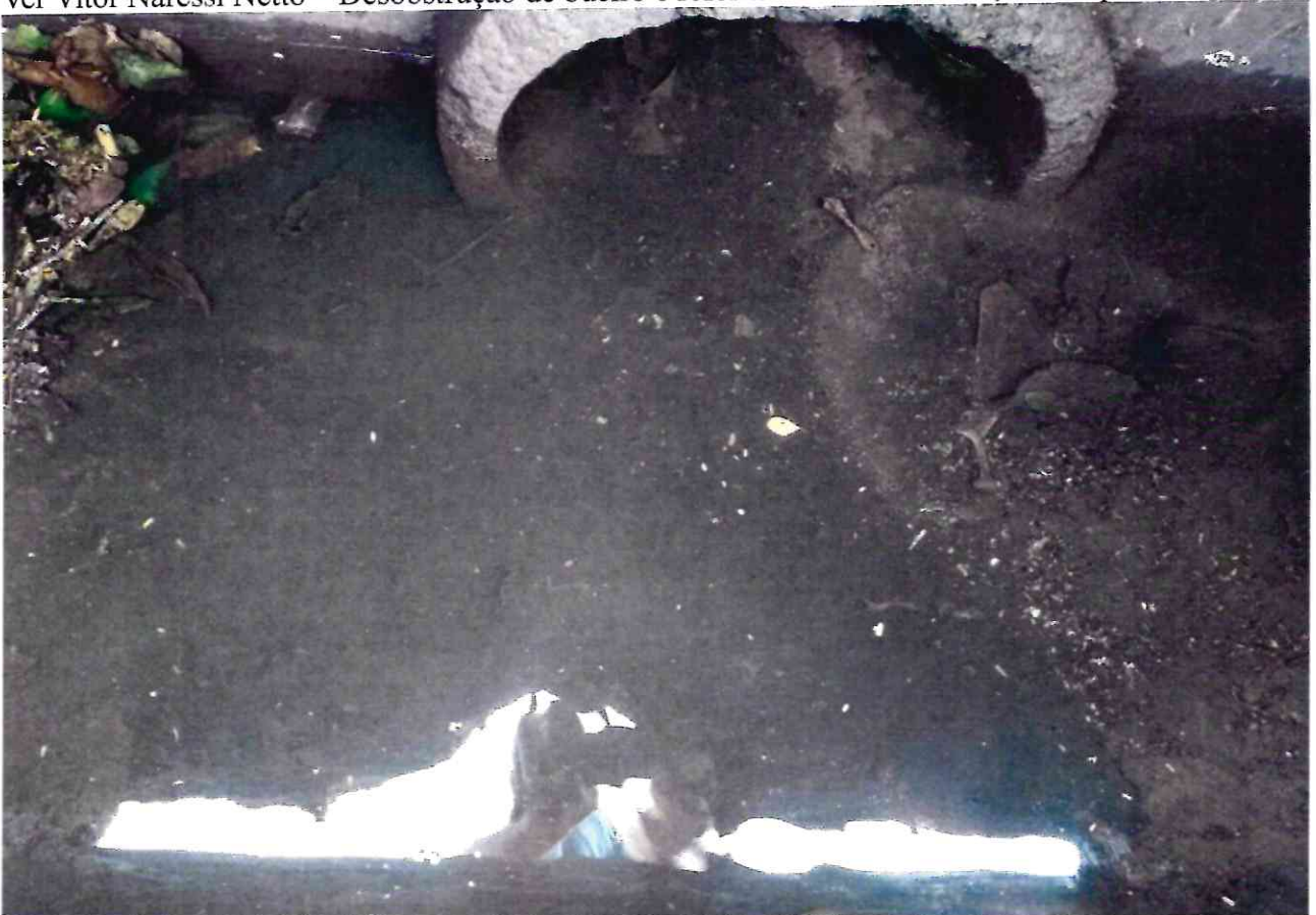
Ver Vitor Naressi Netto – Desobstrução de bueiro e reforma de boca de lobo, Rua Equador, nº 64.
