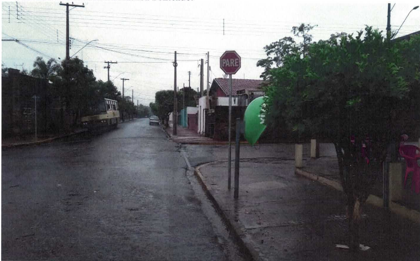
Ver Vitor Naressi Netto – sinalização de solo na esquina da Rua Valentina de Lameida Prado Penteadado com a Avenida Ataliba Penteadado.
