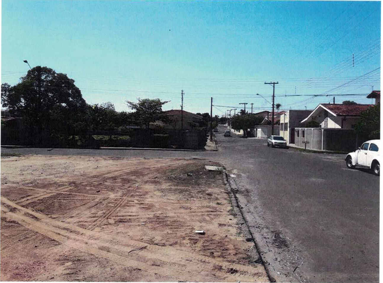
Ver Vitor Naressi Netto – sinalização de solo “PARE”, cruzamento da Rua Cristiano Franco com a Rua Pedro Verona, Jardim Verona.
