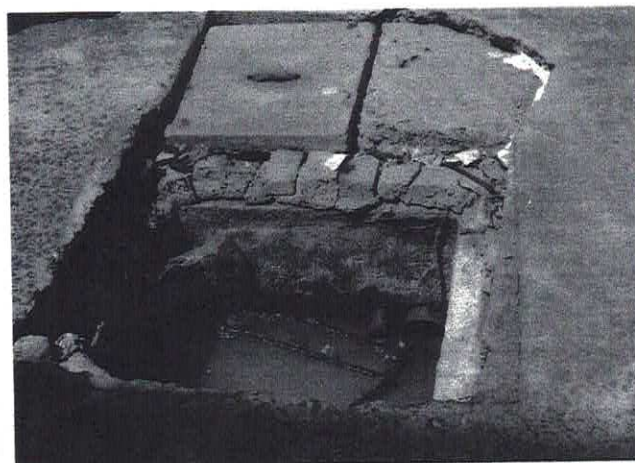
Detalhe da caixa de inspeção de esgoto
