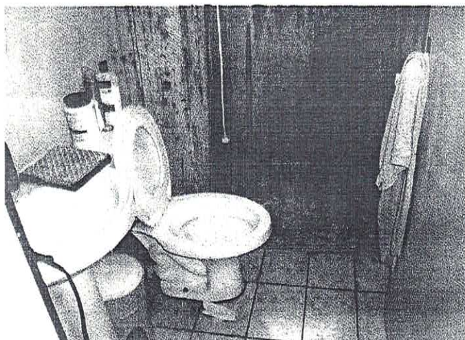
Vista do banheiro do apto 21
