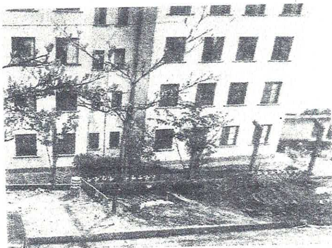
Obra feita na parte externa do condomínio
