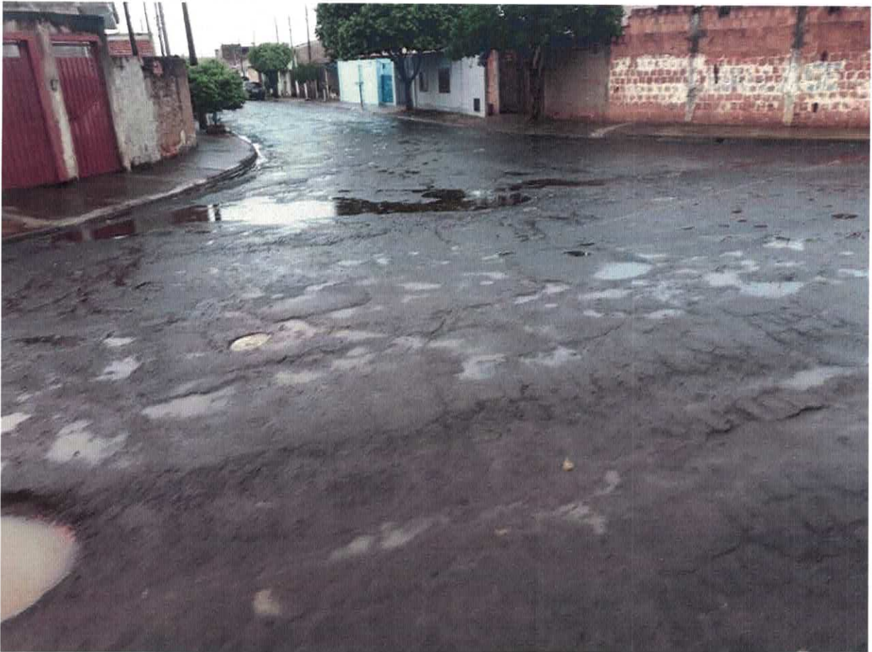
Manutenção asfáltica na rua Ângelo Capelo, Jd São Lucas , próximo ao número 514. Ver. Vitor Naressi Netto
