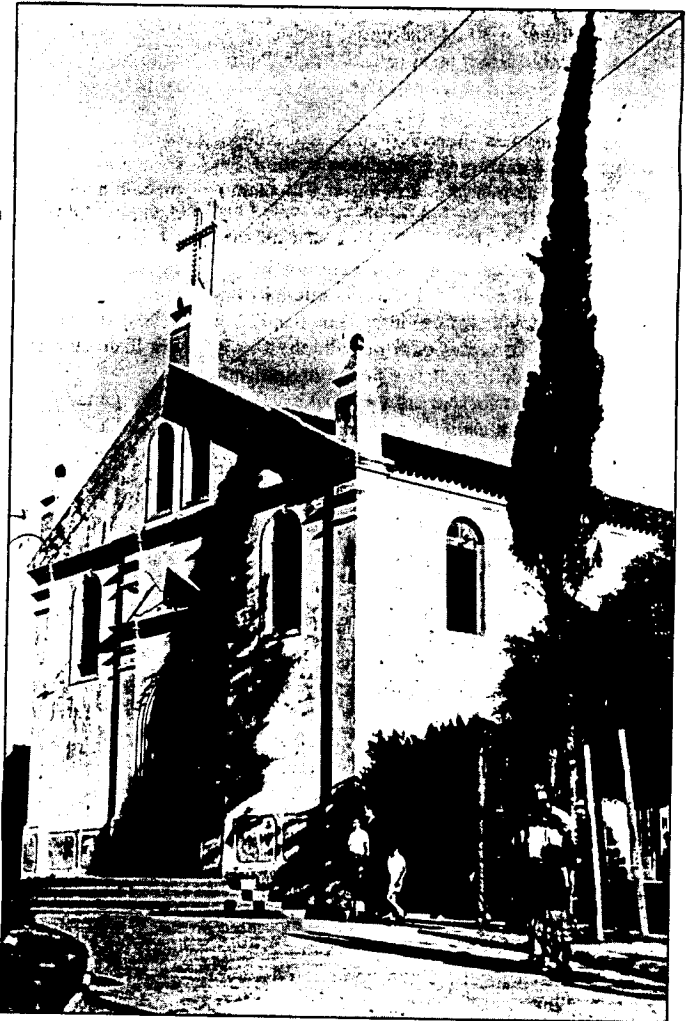
O cipreste, ao lado da Igreja São José, teve de ser rodeado com estaca alta, para impedir que o matassem.
