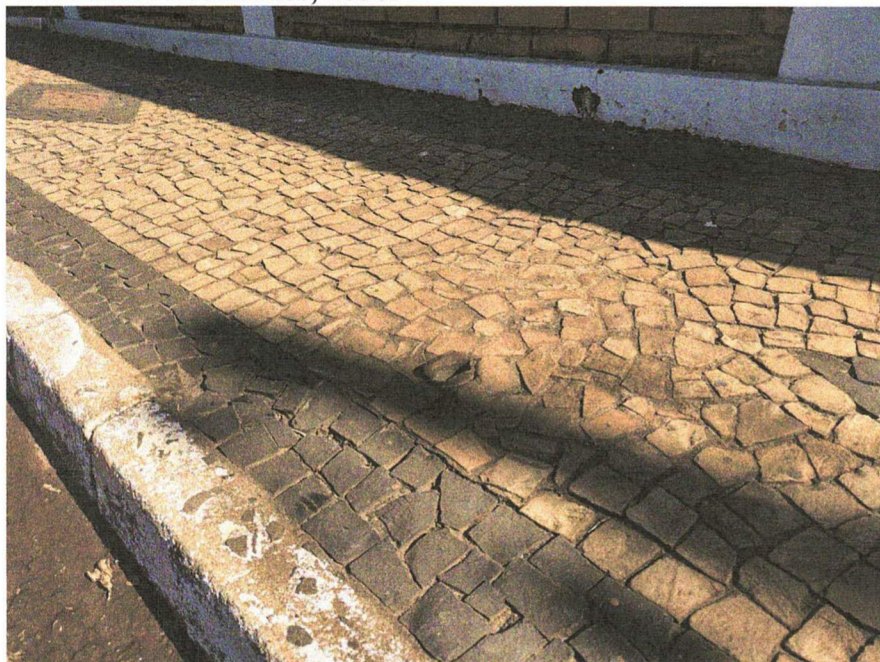
Ver César Ramos da Costa “Cesinha” – reparo em estrutura metálica em calçada na Avenida Preudente de Moraes, 1656.
